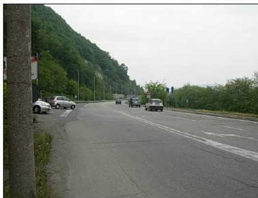
Vista da SSW
