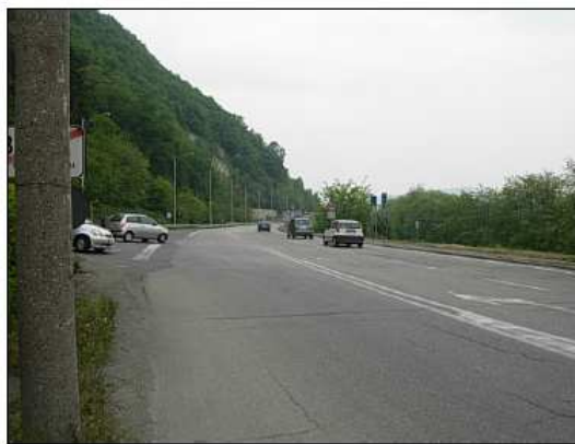
Vista da SSW
