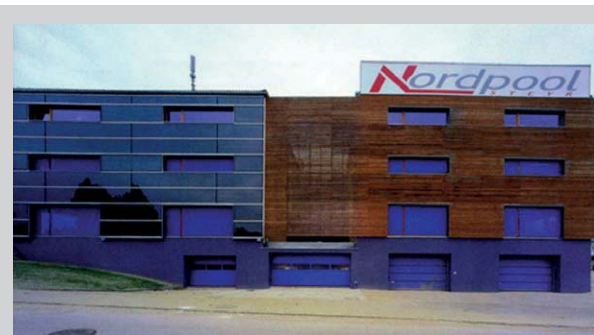
Inserimento di pannelli solari termici in facciata in una operazione di recupero di fabbricati produttivi esistenti.
